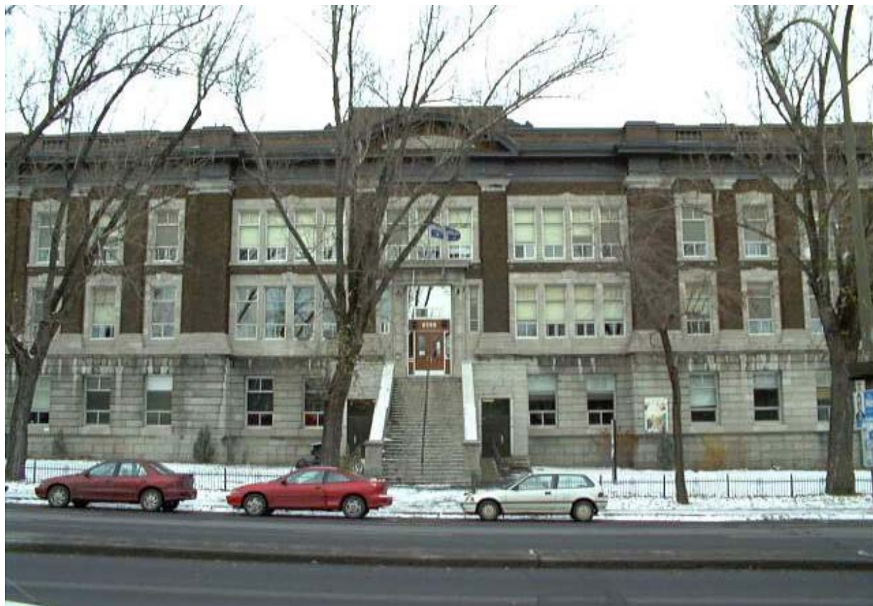
Saint-Jean-Baptiste-de-la-Salle, vue de la façade Ouest, Isabelle Bouchard et Gabriel Malo, novembre 2000
