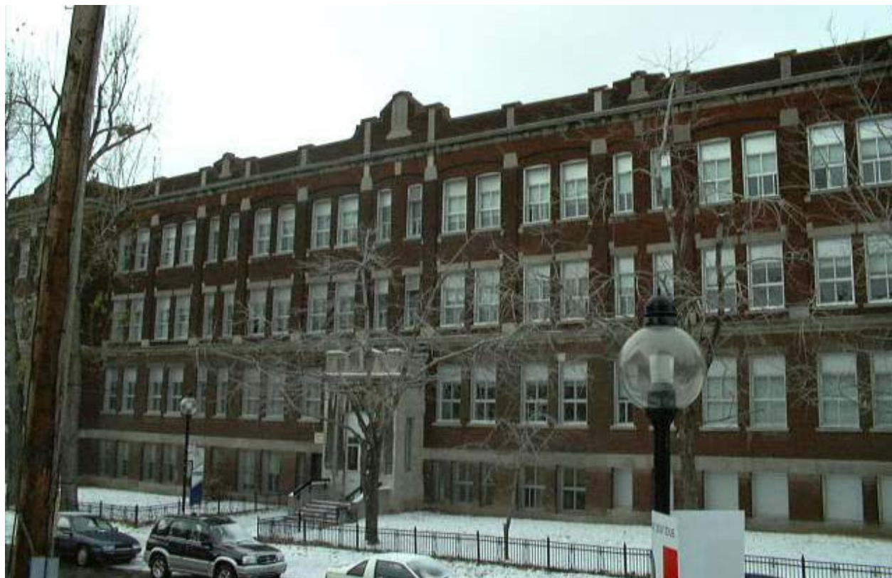
Saint-Nom-de-Jésus, rue Adam, vue de la façade Sud, Isabelle Bouchard et Gabriel Malo, novembre 2000
